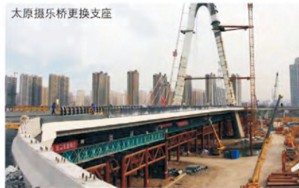
太原摄乐桥更换支座
